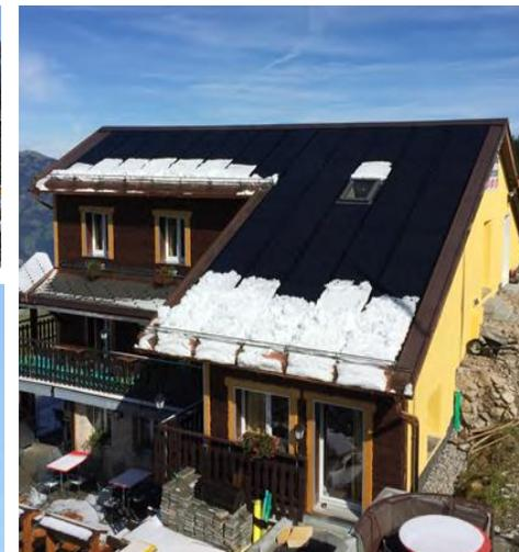
Per quanto riguarda la copertura del progetto sono stati invece apposti moduli di tipo tradizionale con cornice e di colorazione nera. Questo tipo di moduli pur essendo di maggior impronta visiva permettono una produzione di 330 Wp a modulo per 60 celle sfruttando la tecnologia Back Contact. Questo nuovo sistema permette, tramite le nuove tecnologie di backsheet e collegamento tra le celle, una maggiore potenza rispetto ai moduli standard tradizionali.
